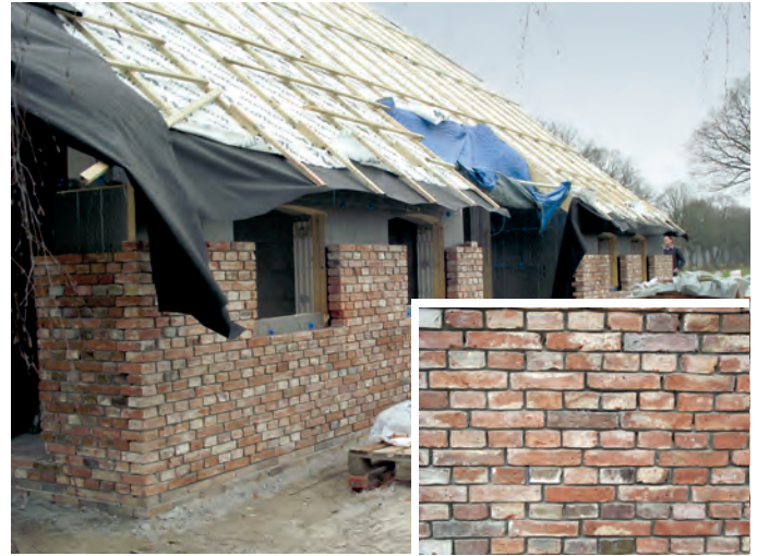
Abb. 3a–c: Wer ein neues Gebäude mit historischen, alten Klinkern bestellt und ein solches Mauerwerk wie hier gezeigt bekommt, kann getrost der Abnahme entgegen sehen
