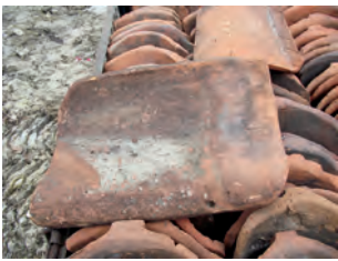
Abb. 2a–c: Die vereinbarte Beschaffenheit von 100 Jahre alten Ton-Dachpfannen kann nur die Beschaffenheit von 100 Jahre alten Tonpfannen sein (optischer Mangel?), die beschädigten Dachpfannen werden aussortiert, der Rest wird verlegt
