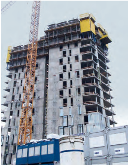
Abb. 2: Kleine Baustellen bedeuten kleine Schlussrechnungen, große Bauvorhaben enden mit aufwändigen Abrechnungen – es ist unschwer nachzuvollziehen, dass Großprojekte in baubetrieblicher Hinsicht anspruchsvoll sind und von Beginn an ein überschaubares wie konsequentes Baumanagement erfordern
